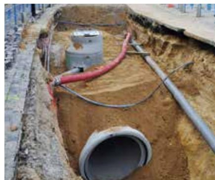
défectueux et de redimensionner les réseaux d'eaux pluviales afin d'augmenter la capacité de stockage et limiter ainsi les risques d'inondations.
