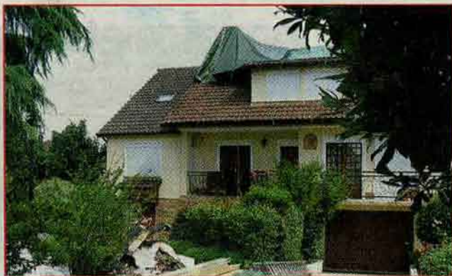
A La Ville-du-Bois, la foudre a frappé l'antenne de ce pavillon.
